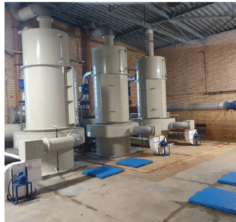
Fot. 3. Remont SUW Strzyżewice – pomieszczenie kaskad
