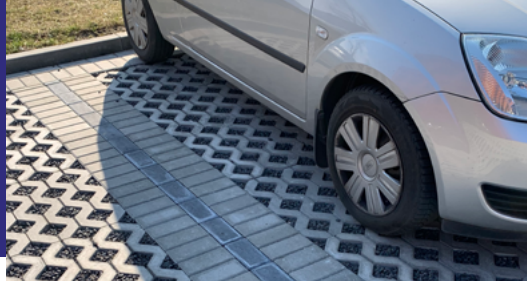
Miejsce postojowe częściowo przepuszczalne z wygodnym dojściem (fot. RetencjaPL)
